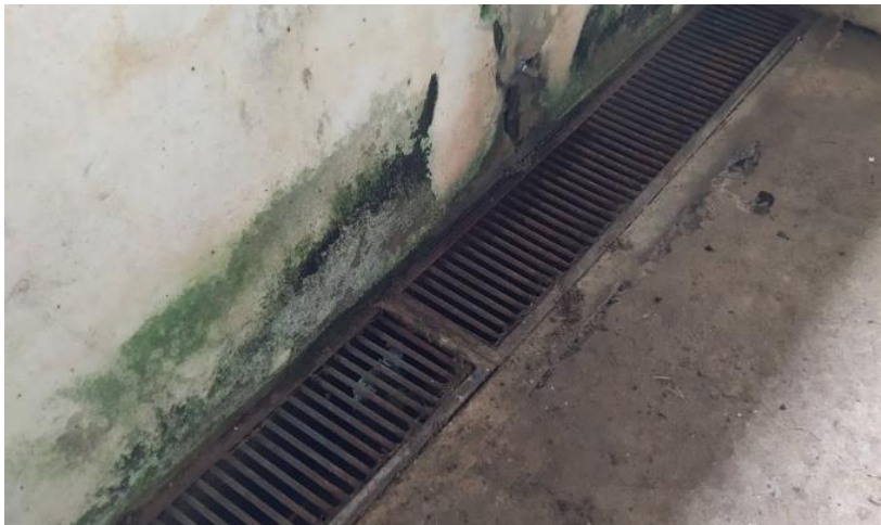
Figura 2. Grade de escoamento de dejetos.
