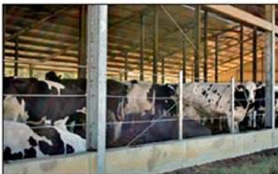
Figura 11: Mureta de concreto.
